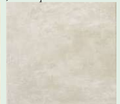
Enduit taloché fin avec badigeon à la chaux, deux teintes différentes
