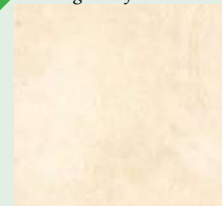
Enduit taloché fin avec badigeon à la chaux, deux teintes différentes
