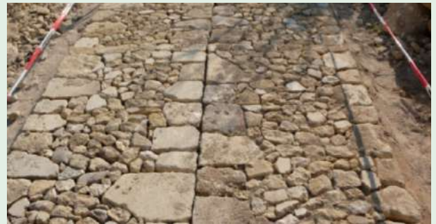
Calade traditionnelle avec pierres de blocage centrales et latérales
