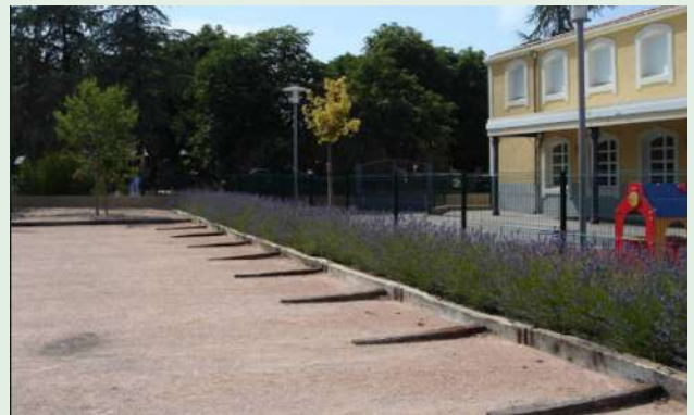
Exemple de stationnement en stabilisé - Plan d'Aups-13
