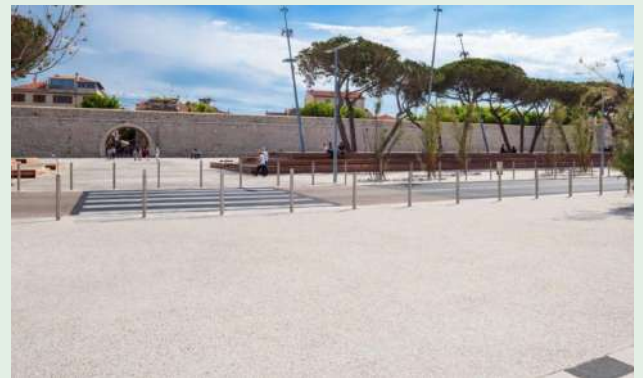
Utilisation du béton désactivé , quai des Pêcheurs, Antibes (06)
