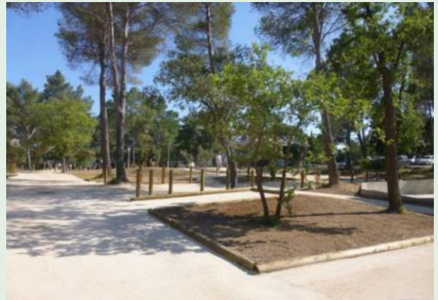
Exemple de stationnement en stabilisé - Aix en Provence -13
