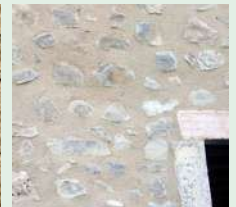
Joints à pierre vue
