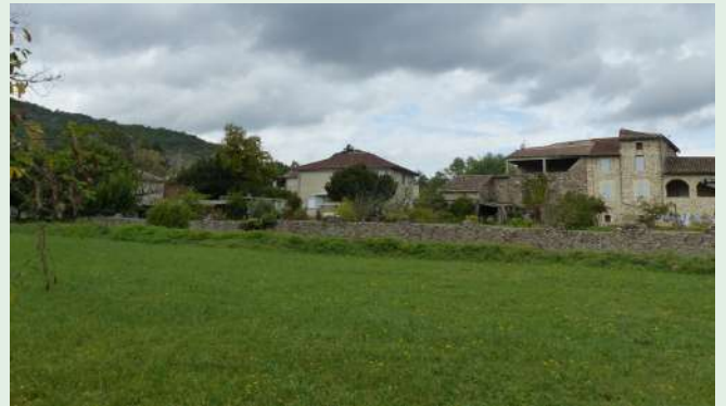
Simple muret de clôture à Poujol servant en plus à canaliser le valat qui chemine à son pied
