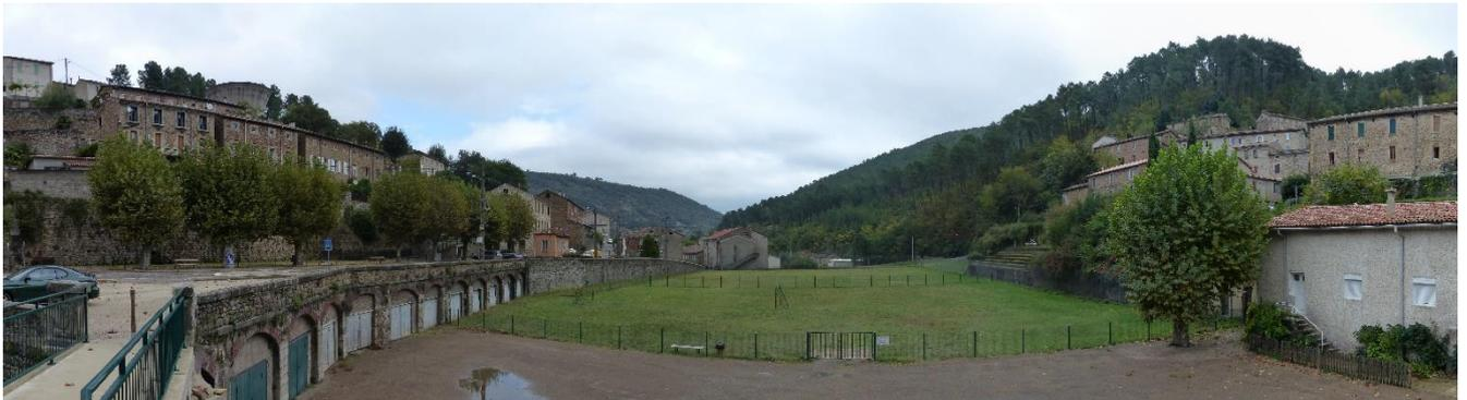
*La couverture du Rieusset constitue une originalité en effaçant provisoirement la présence de l'eau pour permettre un gain d'espace lors de l'extraction minière*
