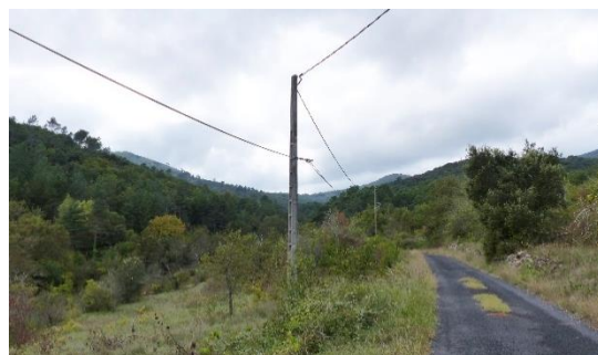
Le chemin des Bois sous le mas des Faysses
